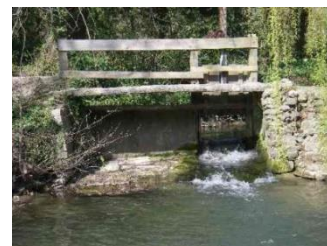
Figure 28 : Vanne du bras de décharge du Moulin de Marquise
