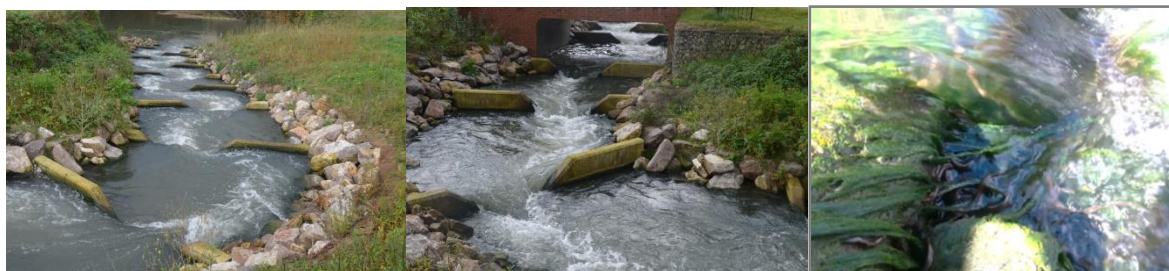
Figure 27 : Pré-seuils du bras de contournement du seuil de Mourlinghen et accumulation d'anguilles observée en 2016
